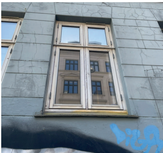
Vinduer udskiftes til nye trævinduer
