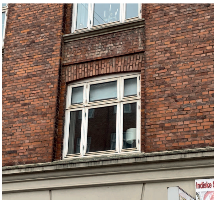
Vinduer mod gade og gård udskiftes
