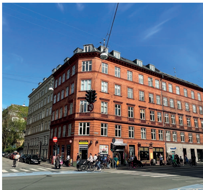
Ejendommen set fra gaden
