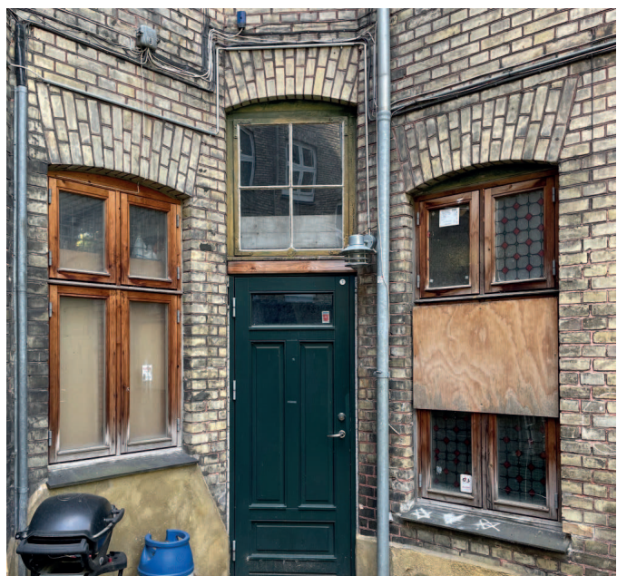
Renovering af vinduer, udskiftning af termoruder til energiglas
