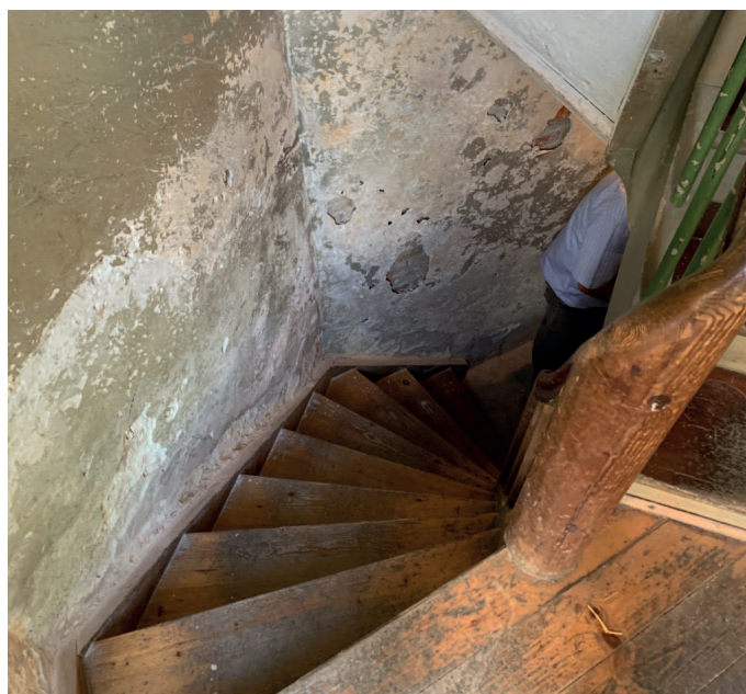
Kælder fugt- og skybrudssikres
