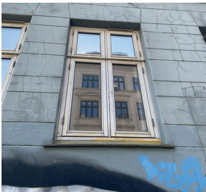
Vinduer udskiftes til nye trævinduer
