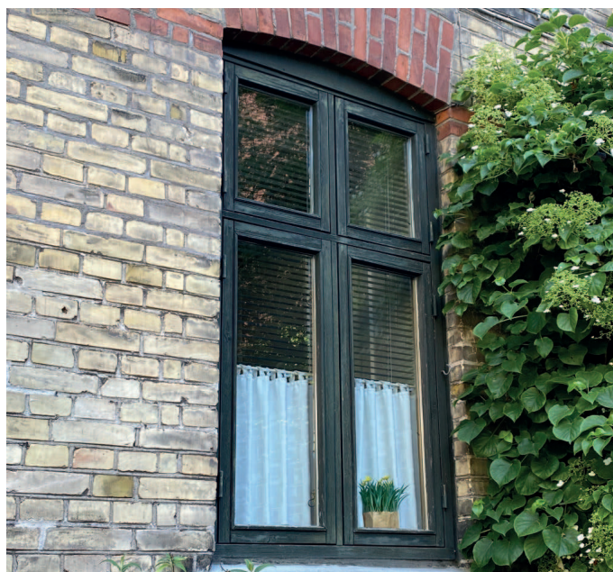
Vinduer udskiftes til nye energivinduer af træ
