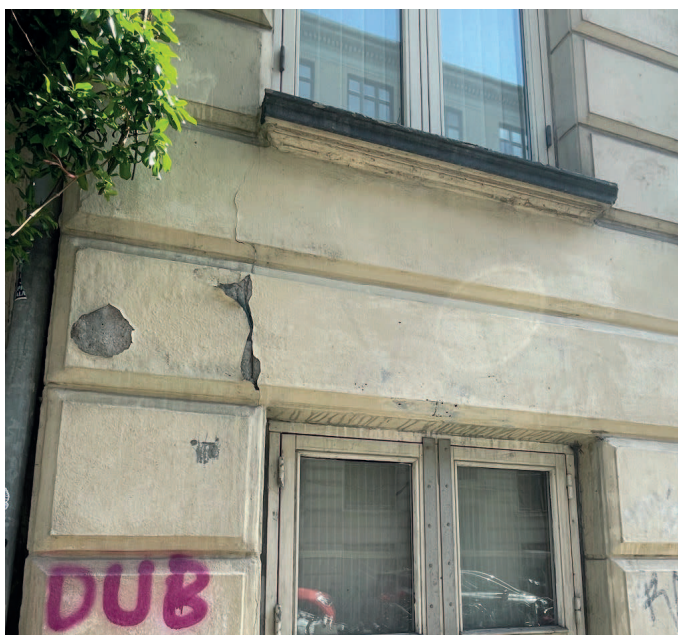
Genopretning af facader, gesimsbånd, sålbænke og sokkel
