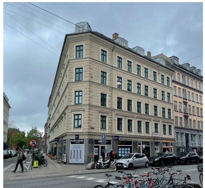
Ejendommen set fra gaden
