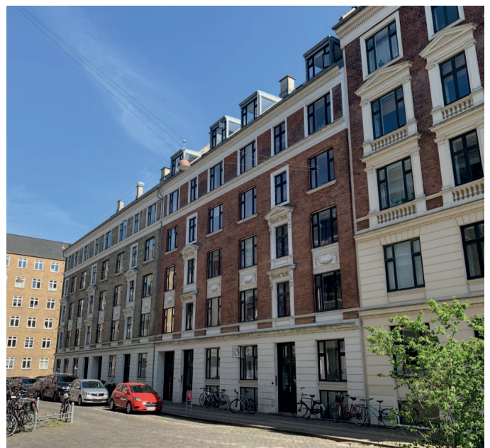
Ejendommen set fra gaden
