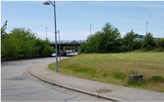
Molestien og viadukten under Bådehavnsgade.
