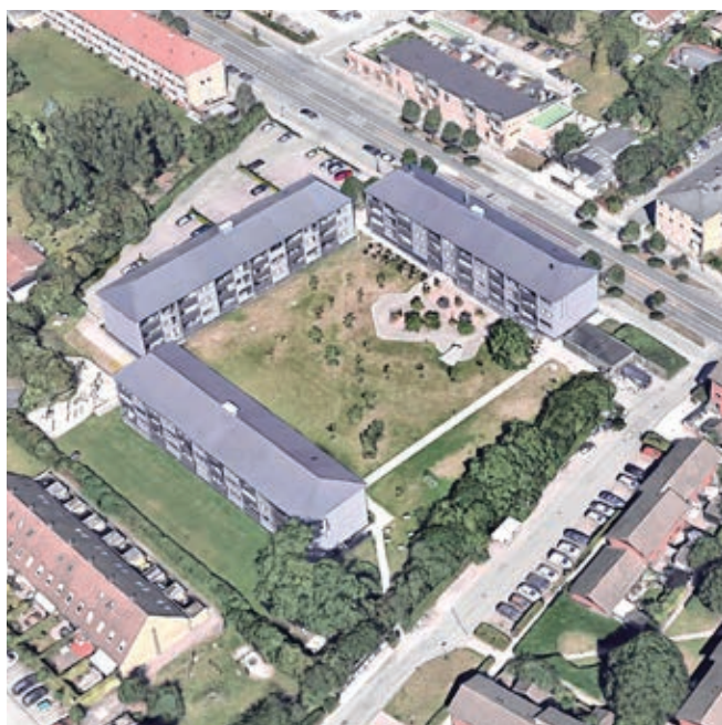
Luftview fra syd af eksisterende forhold
