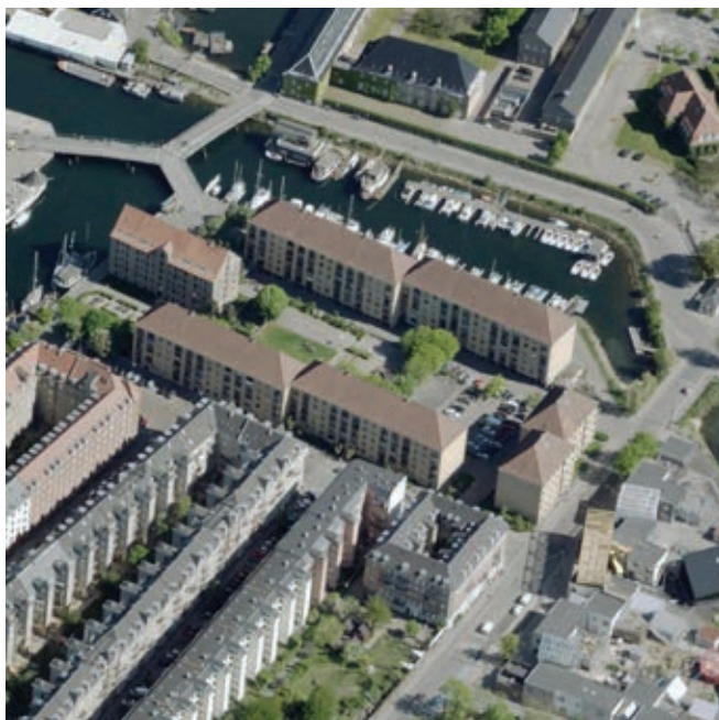
Luftview fra syd af eksisterende forhold
