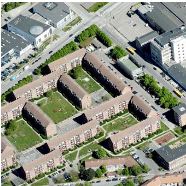
Luftview fra syd af eksisterende forhold
