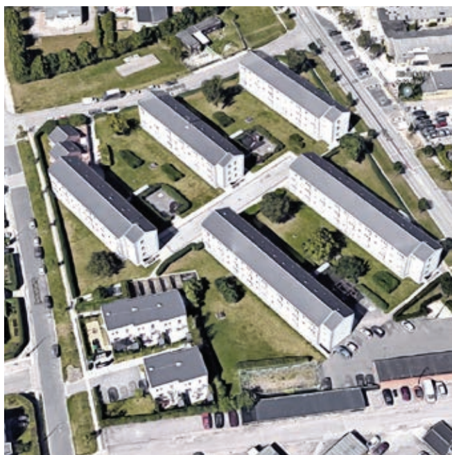
Luftview fra syd af eksisterende forhold
