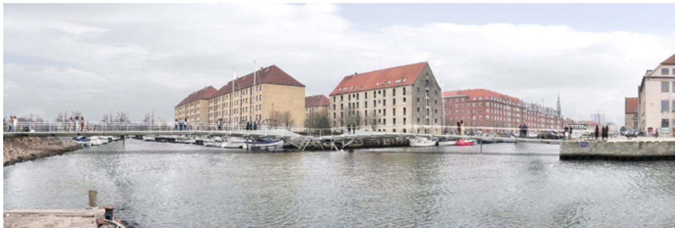
Kanalbro over Trangraven og Christianshavns Kanal.
