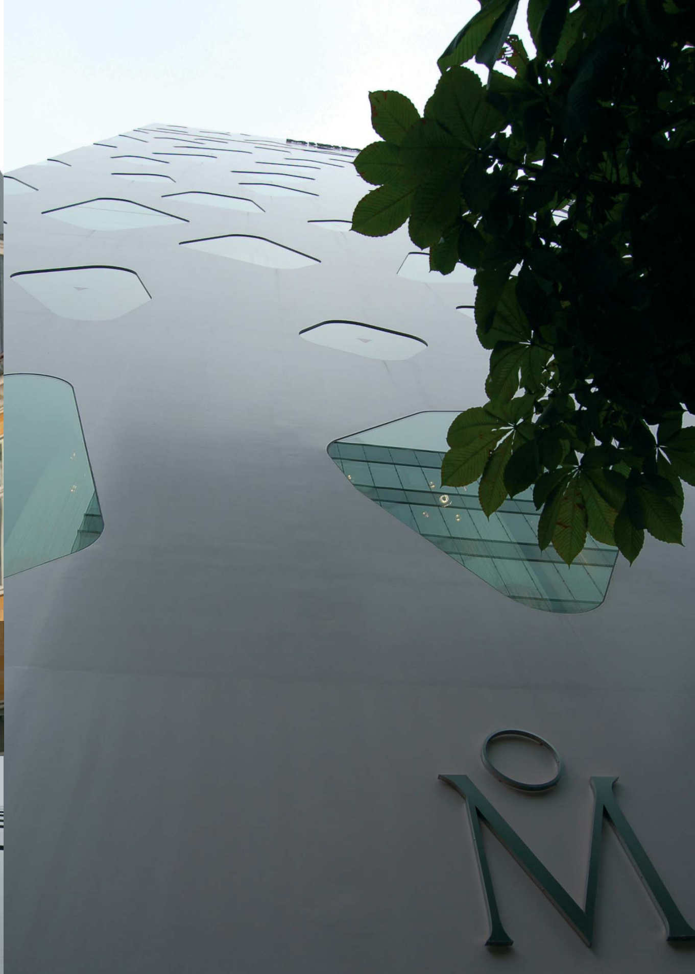
Mikimoto, Tokyo - Toyo Ito Rammeløse vinduers placering i flugt med facadeplan.
