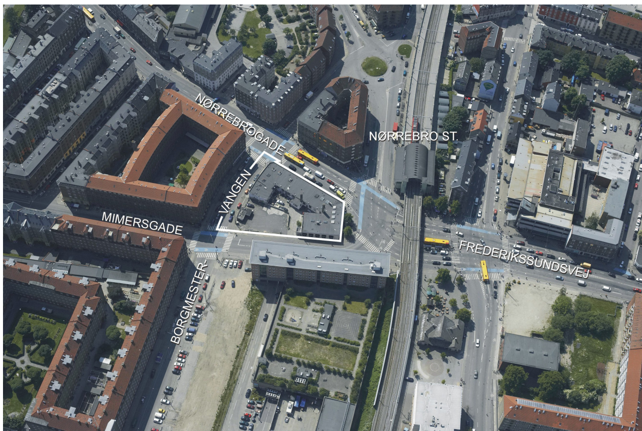
Luffoto fra 2007 af lokalplanområdet (set mod syd) omgivet af ældre karrébebyggelse mod øst og syd, samt Nørrebro Station/højbanen mod vest og Føtex-bygningen mod nord.
