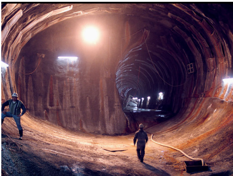
Figur 4.9 Kaverne udført som NATM-tunnel, Københavns Metro.
