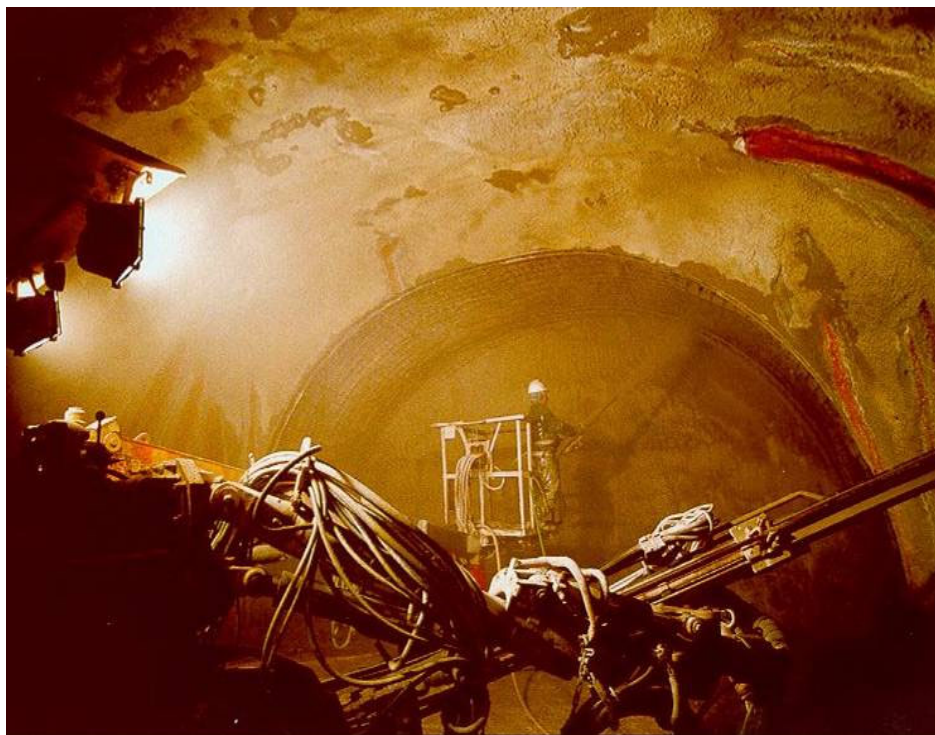
Figur 4.10 Påføring af sprøjtebeton i kaverne, Københavns Metro.
