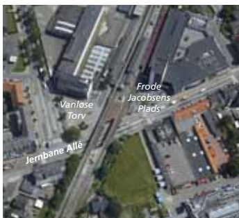
Luftfoto af jernbaneviadukten over Jernbane Allé.
