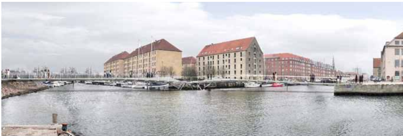
Kanalbro over Trangraven og Christianshavns Kanal.
