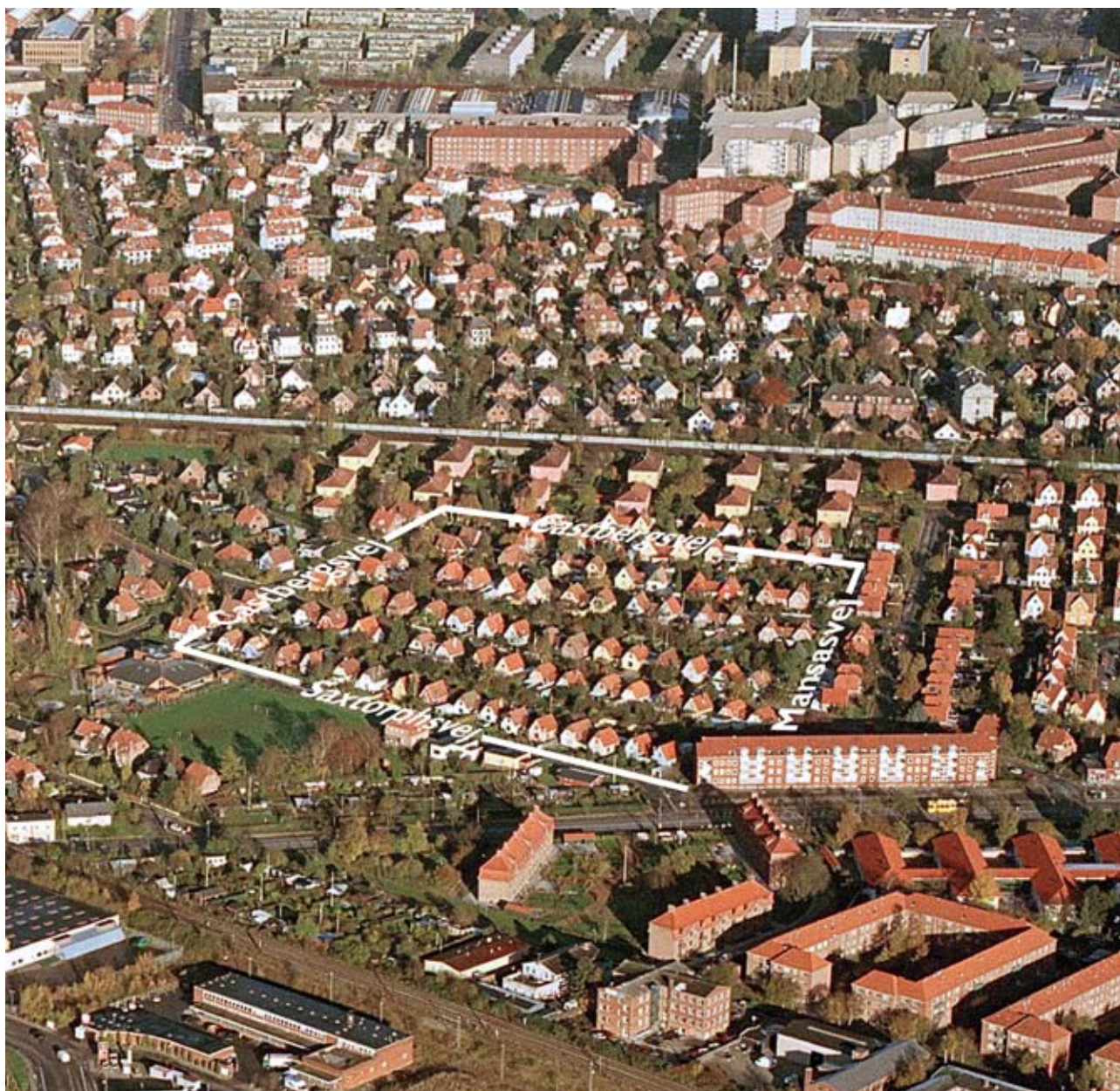
Grundejerforeningen Valby Vænge udgør ca. 5,3 ha, mellem, Mansasvej, Saxtorphsvej og Castbergsvej i Valby. Luftfoto af området set mod nord (JW Luftfoto juni 2005).
