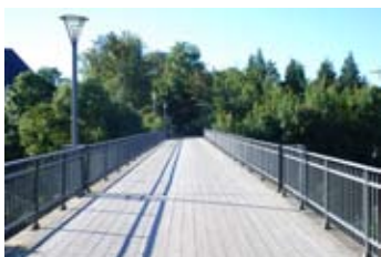
Broen over banen, der er en cykelgangsti.
