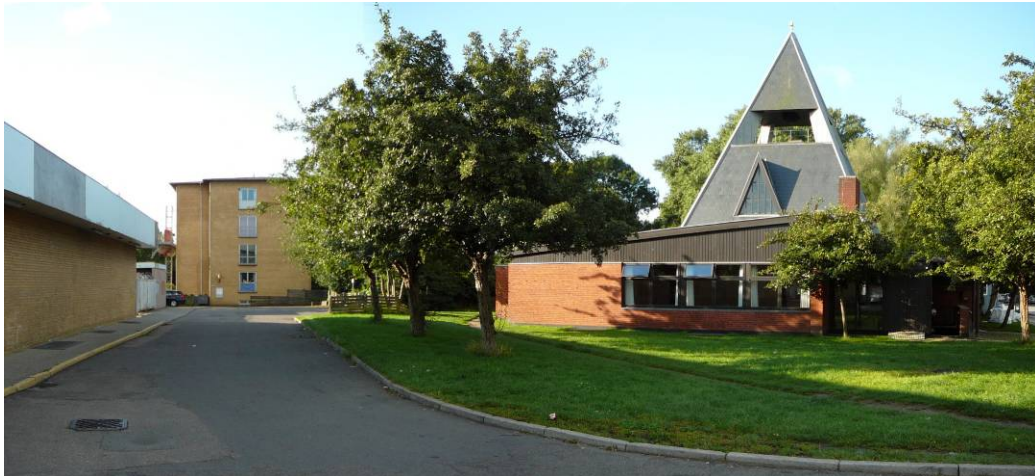
Foto 1 Lundehus Kirke ses til højre i billedet. Bygningerne til venstre i billedet risikerer at blive fjernet, afhængig af valg af tilkørselsrampe.
