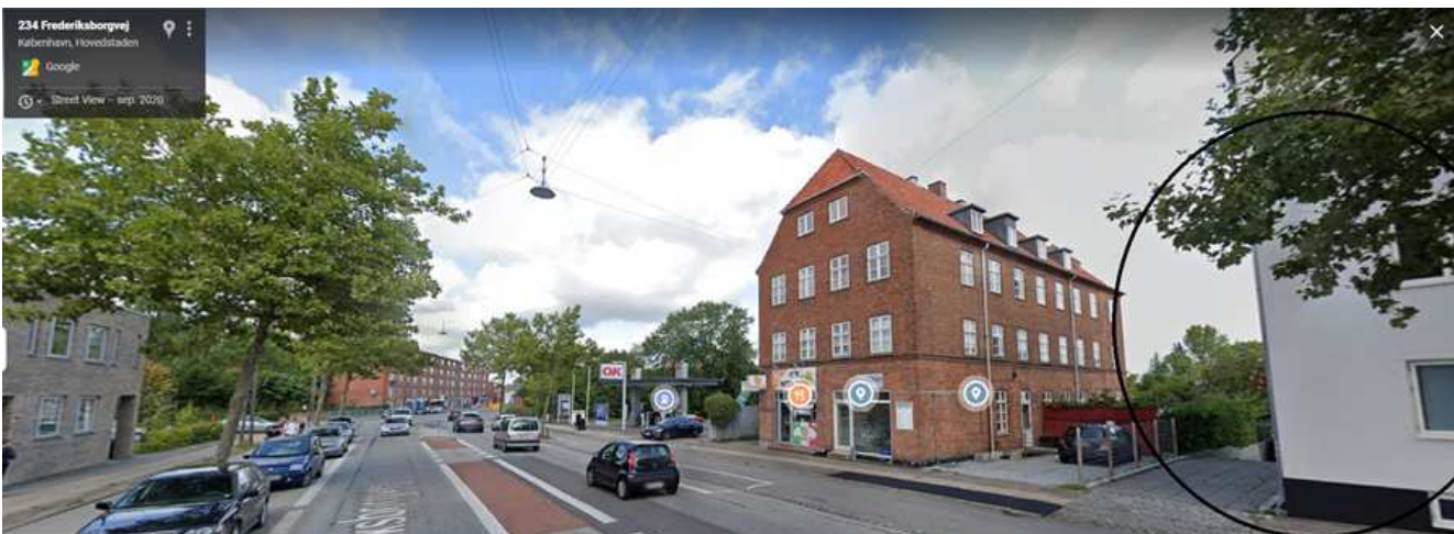
Kig den anden vej ned af Frederiksborgvej med tankstation og højere etagebyggeri kort derfra.
