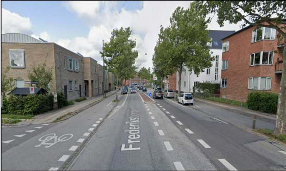
De nærmeste ejendomme ved Frederiksborgvej 234 (Hvid ejendom).
