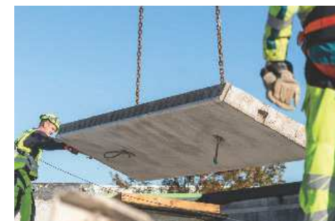
Direkte genbrug af beton element som "fyld" mellem stålprofiler
