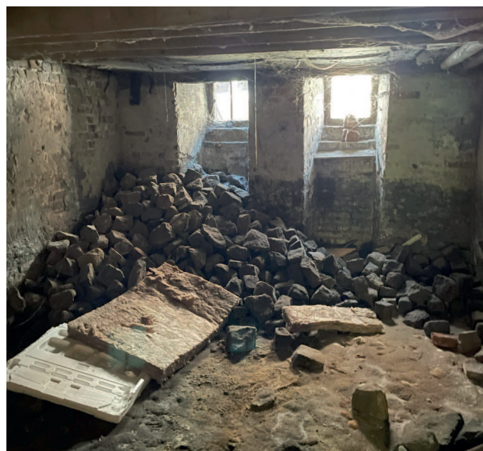
Fugt- og brandsikring af kælder
