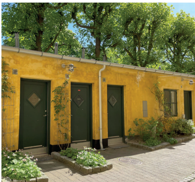
Indeliggende bad i 5 boliger, der mangler
