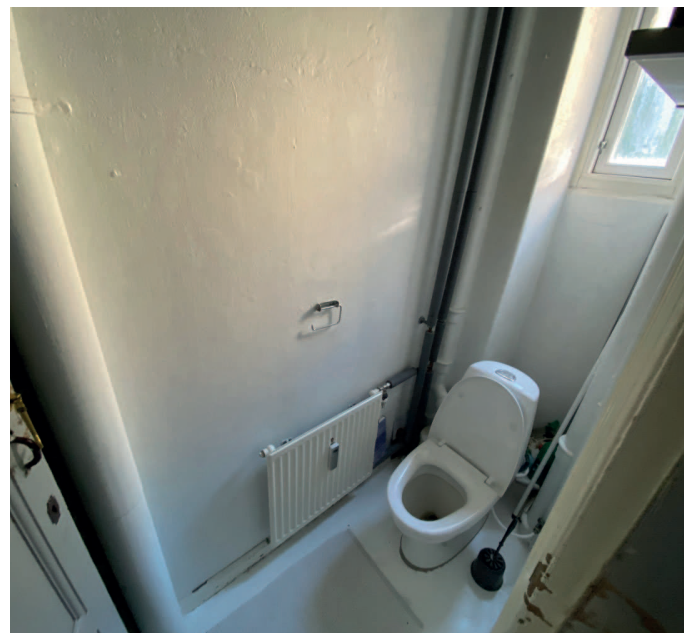
5 boliger har udeliggende wc/bad på bagtrappen
