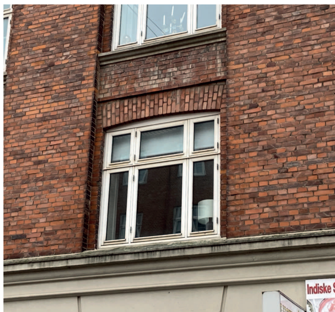
Vinduer mod gade og gård udskiftes
