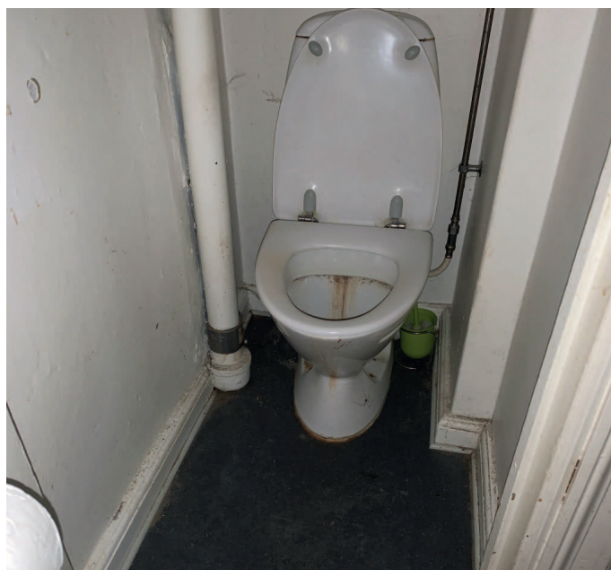
Indeliggende bad i 8 boliger, hvor der mangler
