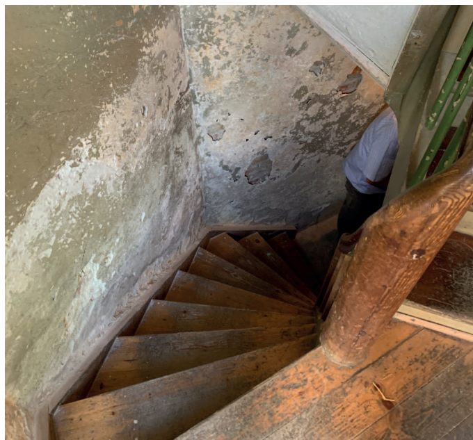
Kælder fugt- og skybrudssikres
