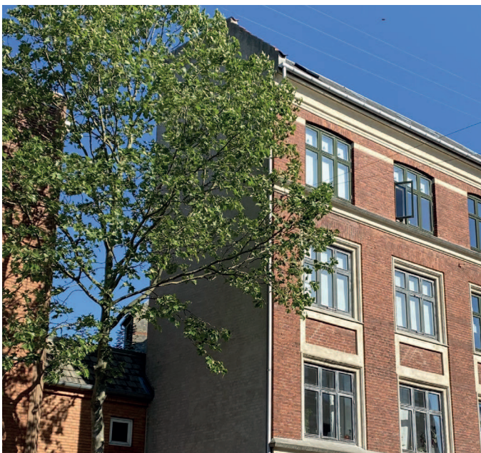
En af ejendommens uisolerede gavle
