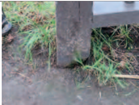
Foto 80: Rækværkscepter: Råd i scepter sat i jord i østlige ende af bro.
