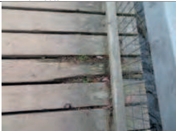
Foto 30: Jord i rille mellem planker og os. bjælker, hvilket medfører fugt og råd i planker, hvilket skyldes manglende renhold.
