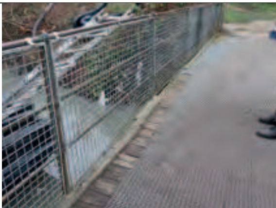
Foto 23: Pressegitter kun fastgjort i toppen. Kan dermed vippes op og være årsag til drukneulykke.
