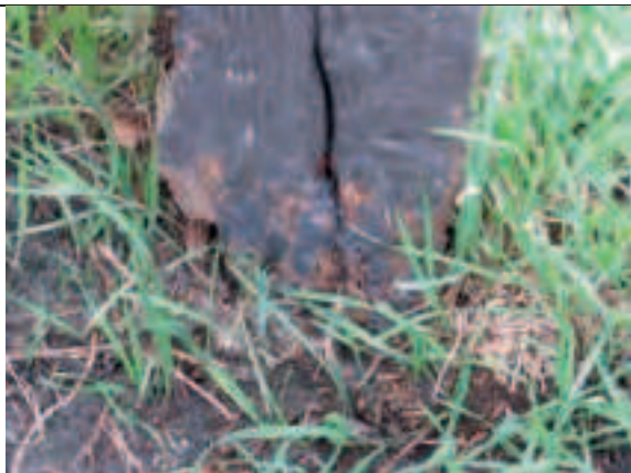
Foto 79: Rækværkscepter: Råd i scepter sat i jord i østlige ende af bro.
