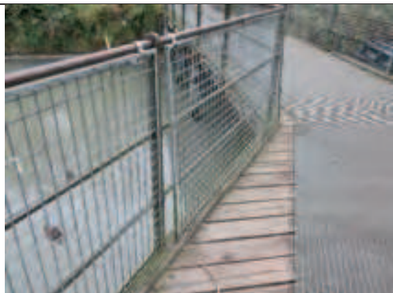
Foto 24: Pressegitter kun fastgjort i toppen. Kan dermed vippes op hvilket kan være årsag til drukneulykke.
