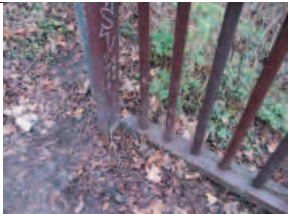
Foto 58: Råd i rækværksscepter og fodliste i nordvestlige ende, hvilket har betydet at fodlisten er knækket og ikke sidder fast i scepteret.
