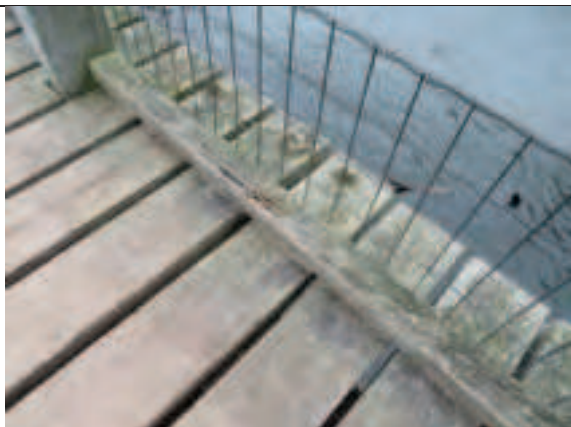
Foto 32: Råd i fodliste pga. manglende vedligehold af træbeskyttelse.
