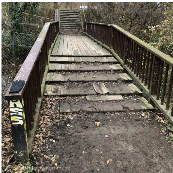
Bro over voldgrav ved Kløvemarksvej
