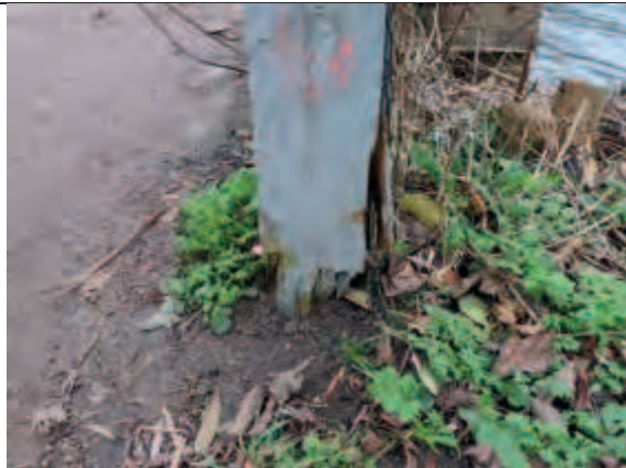
Foto 40: Råd i rækværk scepter i sydlige ende da den er sat i jord
