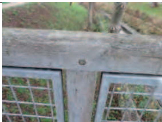
Foto 12: Håndliste og scepter er fastgjort med dyblier. Ingen tegn på skader. Håndværksmæssigt korrekt udført.
