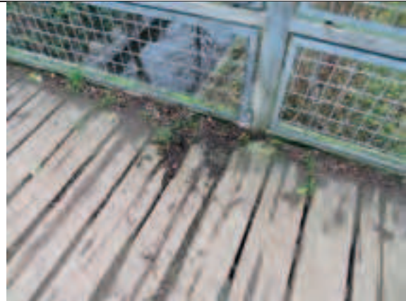
Foto 6: Bevoksning og jord på brodæk pga. manglende renholdelse.
