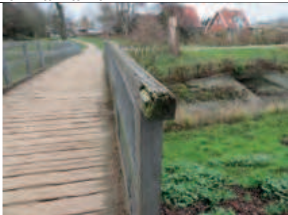
Foto 7: Forvitret håndliste i vestlige ende til ubehag for fodgængere der bruger broen.
