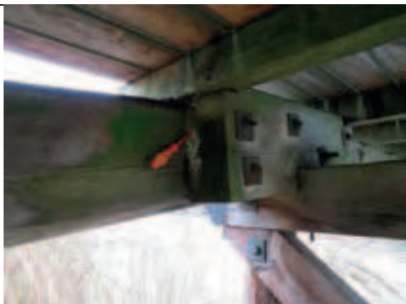
Foto 81: Brounderside: Bærende overbygning generelt i fin stand uden tegn på skader.
