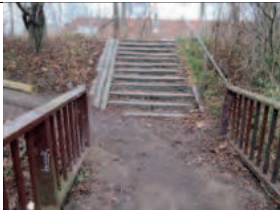
Foto 68: Trappetrin i vestlige ende af bro er meget ujævn og kan være årsag til faldulykker
