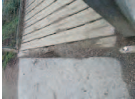
Foto 4: Plankedæk ved broende i vest med råd
