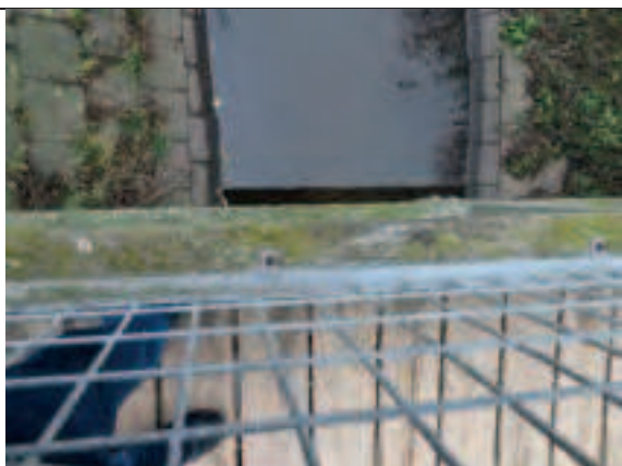
Foto 11: Algevækst på yderside af knæliste og fodliste pga. manglende renhold. Bør afrensnes mindst 2 gange om året.
