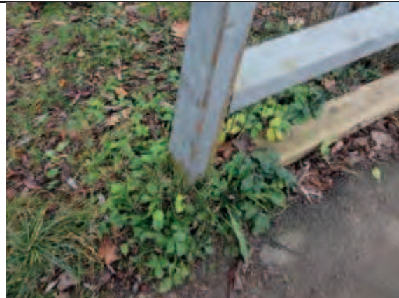
Foto 41: Råd i rækværk scepter i sydlige, pga. den er sat i jord
