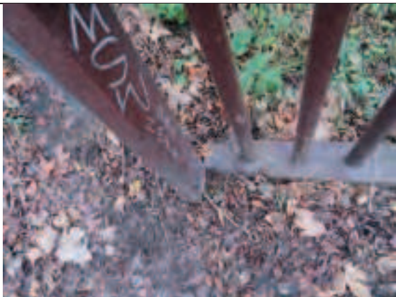
Foto 59: Råd i rækværksscepter og fodliste i nordvestlige ende, hvilket har betydet at fodlisten er knækket og ikke sidder fast i scepteret.
