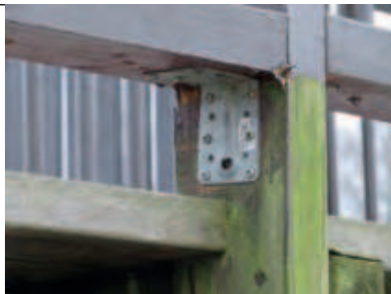
Foto 82: Fodliste: Nye vinkelbeslag er tegn på at fodlisten er udskiftet.
