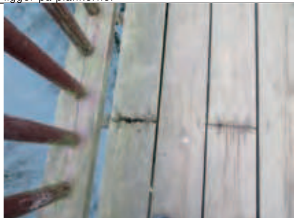
Foto 54: Brodæk i vest. Råd i samling mellem to planker.
