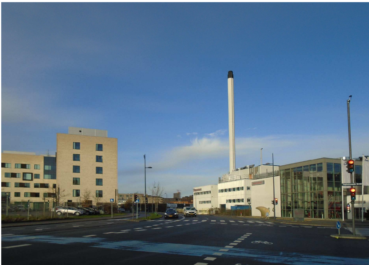
Eksisterende forhold, set fra Tegllholmsgade ved Støberigade.
