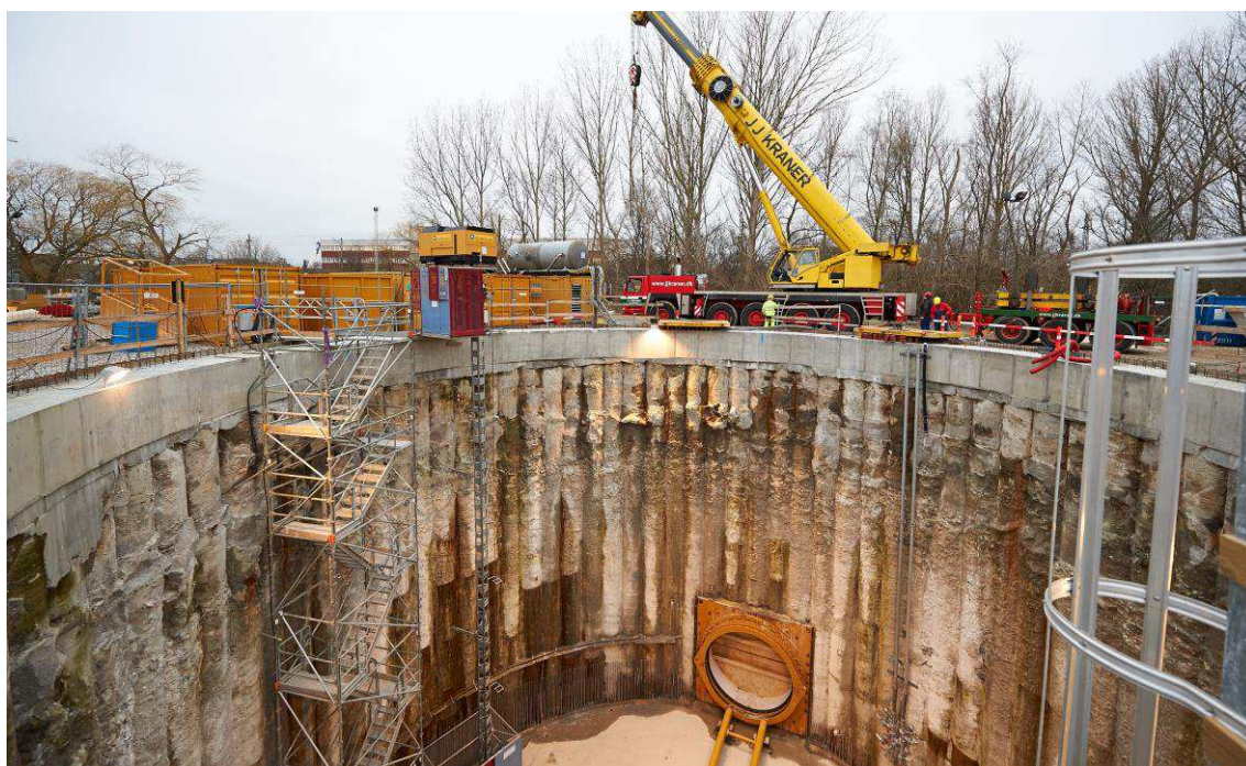
Figur 5.6 Skakt udført med sekantpælevæg.
