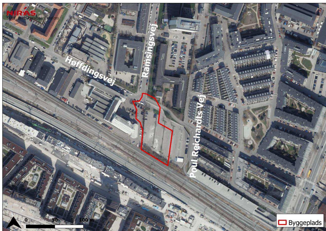
Figur 15.2: Byggepladsen ved FLSmidth
