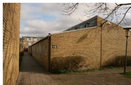
Institutionsbygninger i 1 etage og med forskudte tage
