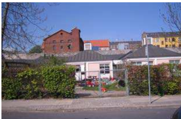
Området syd for lokalplanområdet fremstår grønt med fritliggende institutioner mv.
