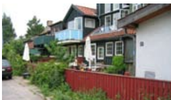
Langs Refshalevej er der opført knopskydninger på de eksisterende bygninger.
