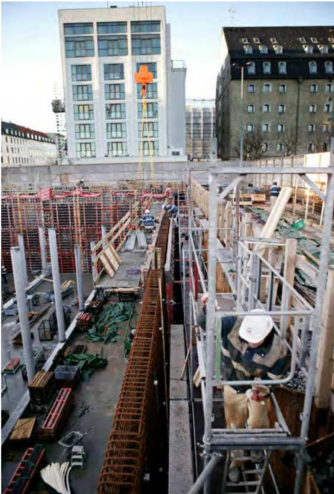
Foto 13 Komplekse anlægsarbejder ved Sankt Annæ Plads
