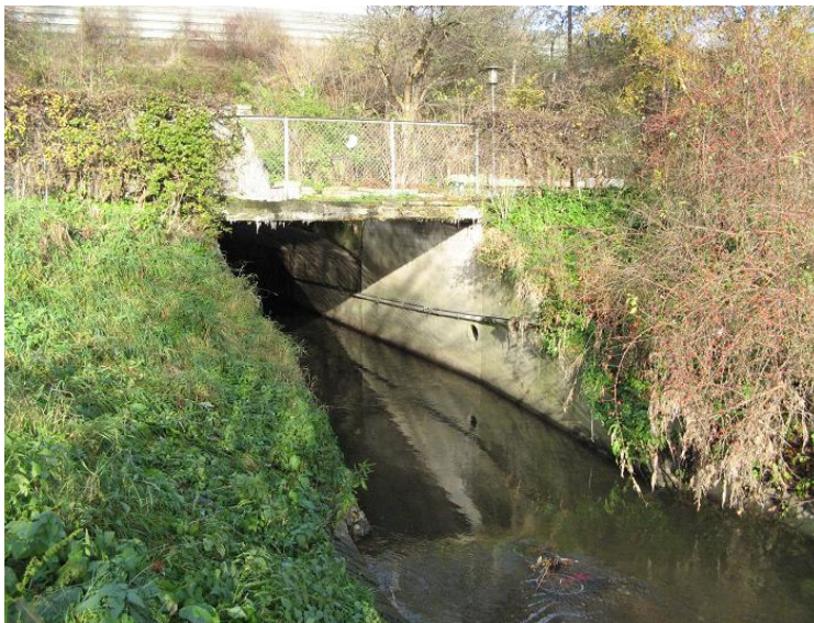
Figur 6-19 Harrestrup Å ved krydsning med jernbanen. Her kan der etableres banketter til faunaen.
