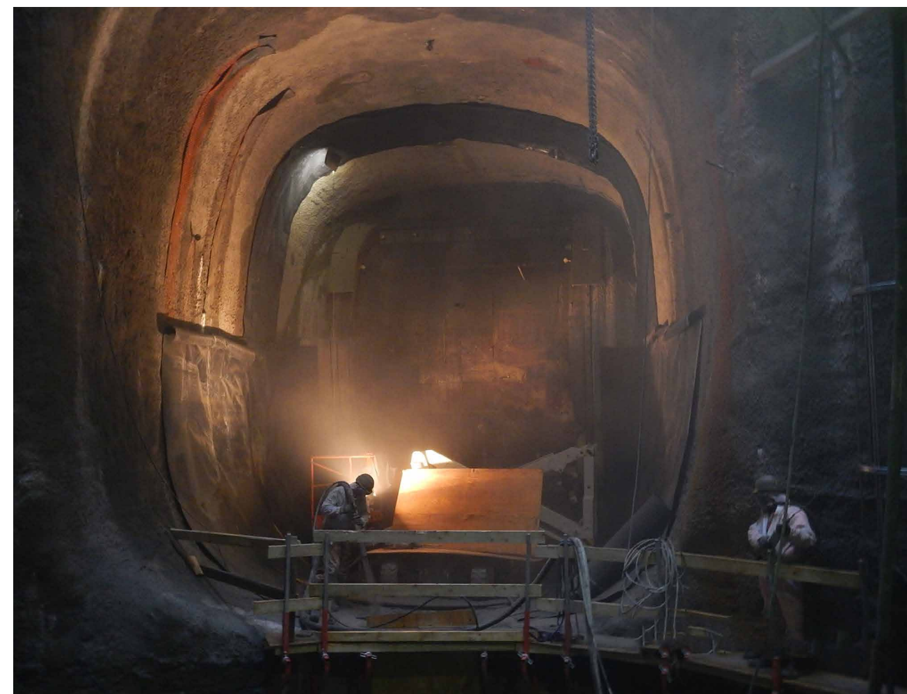
Redningsskakt i Krauseparken. I fremtiden vil der være hul helt ind til de to metrotunneler, den cylinderformede skakt er placeret imellem.
