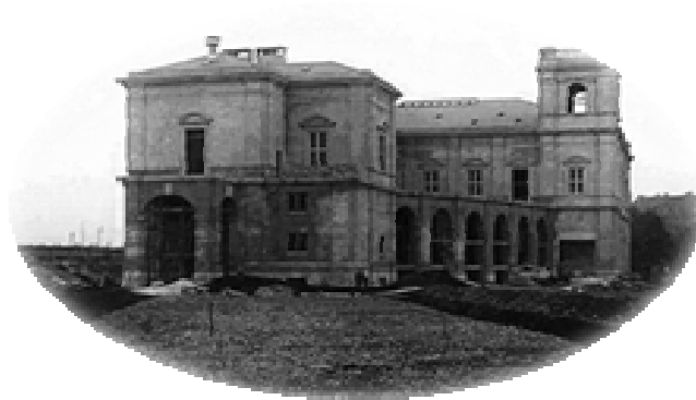
Billede af den eksisterende Palads Bygning fra 1918
