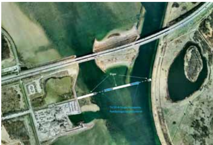
Figur 7: Etablering af sikringsanlæg syd for Kalveboderne.
