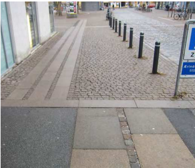
Foto der viser problem 13_2: Forbindelse
