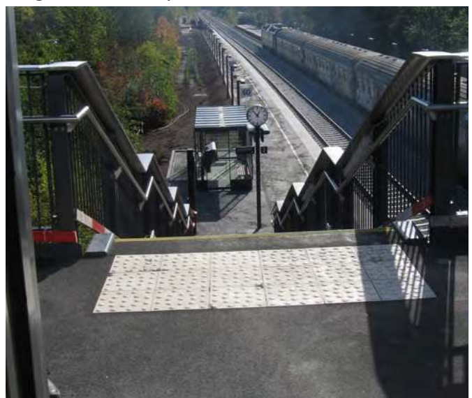
Eksempel på opmærksomhedsfelt udført af kunststof til montering på asfalt (referencefoto)
