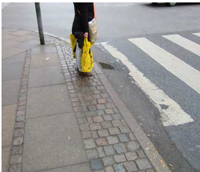
Problem 08_2: Rampe er uden kantopspring og er for stejl og defekt. Desuden ligger der en rist i rampen.
