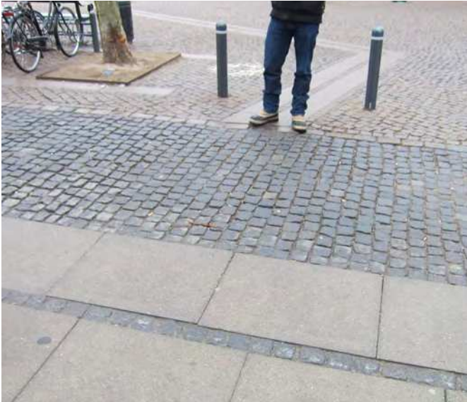
Foto der viser problem 13_1: Tilkobling
