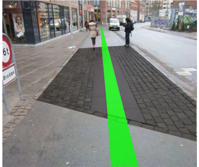
Løsningsforslag 03_1: Særlige ledelinier lægges ned i asfaltbelægningen.
