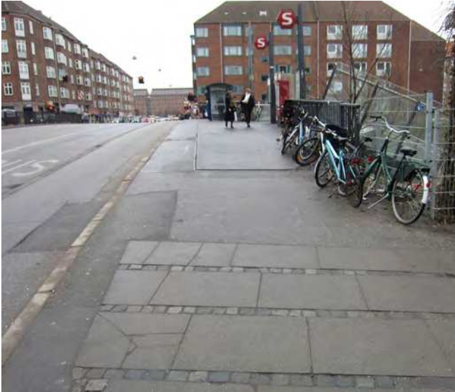
Problem 17_1: Der mangler ledelinie på fortov
