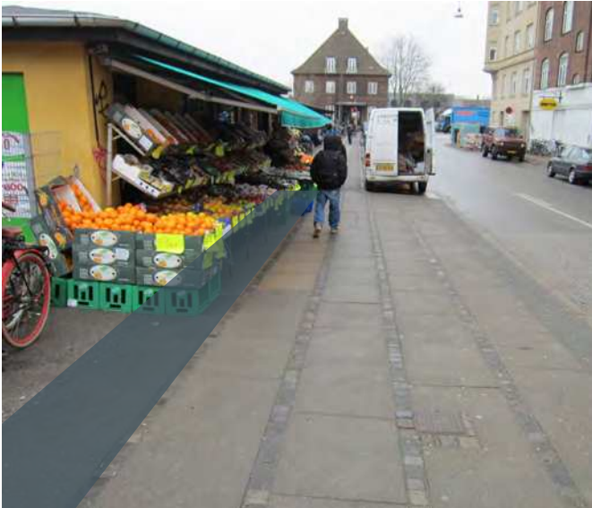
Løsning 17_2: Fortov isoleres med chausséstensbånd i siderne
