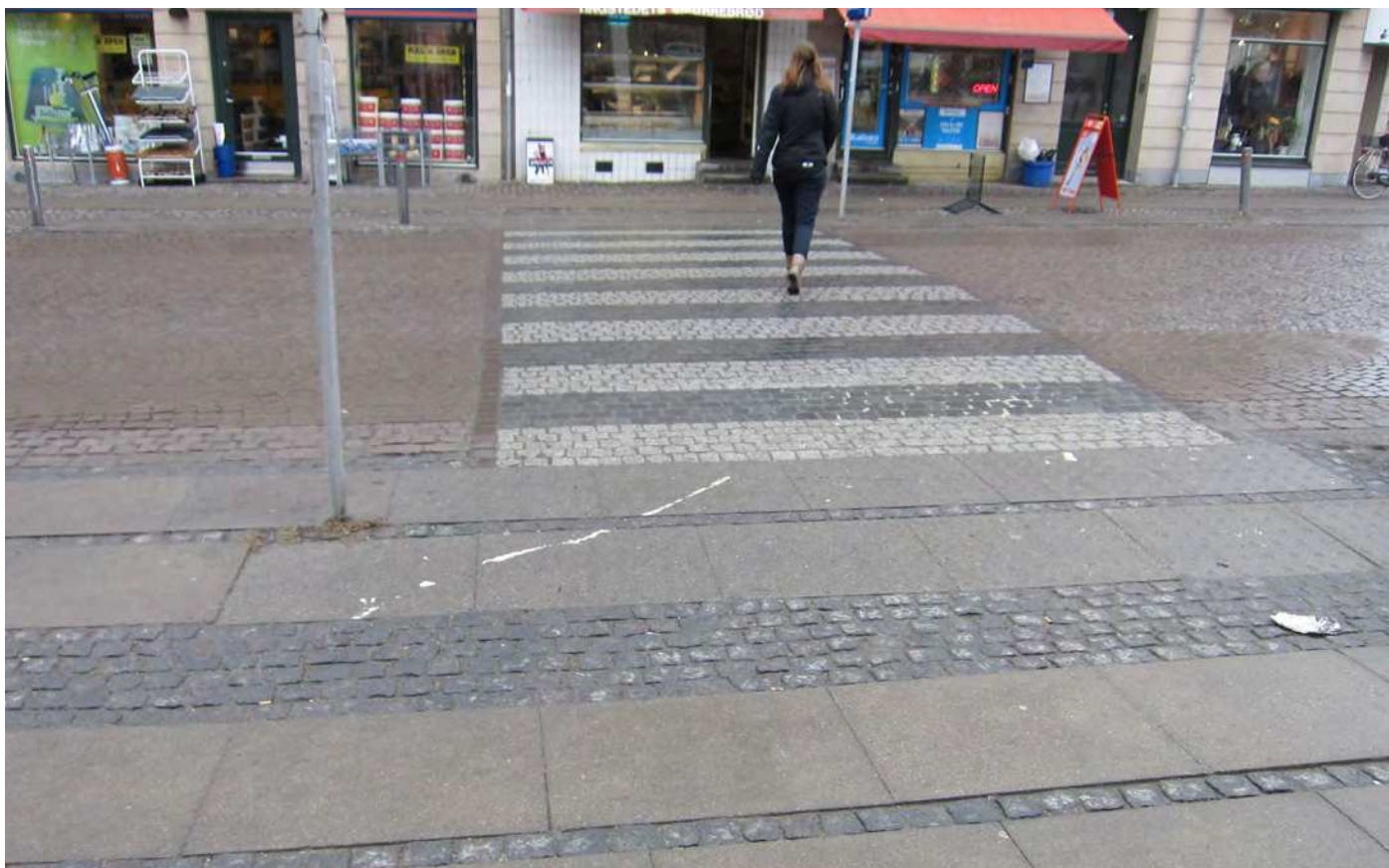
Foto der viser problem 13_5: Forbindelse til fodgængerfelt
