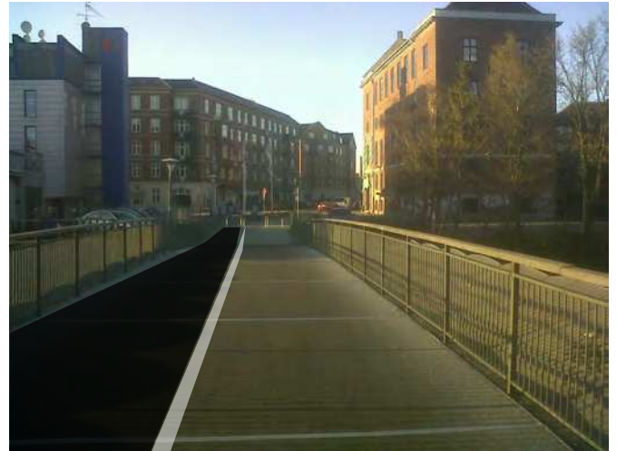
Løsningsforslag 20_1: Broen deles i en gang- og en cykeldel.
