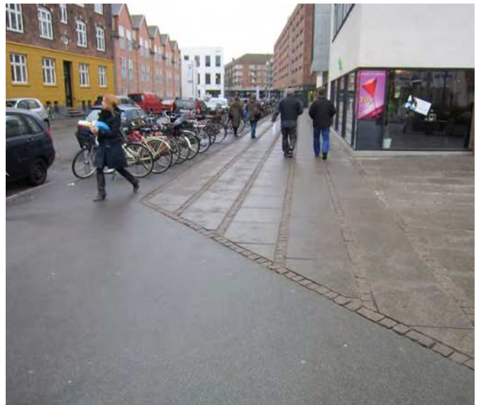
Problem 18_2: Kobling til fortov ved Spinderiet
