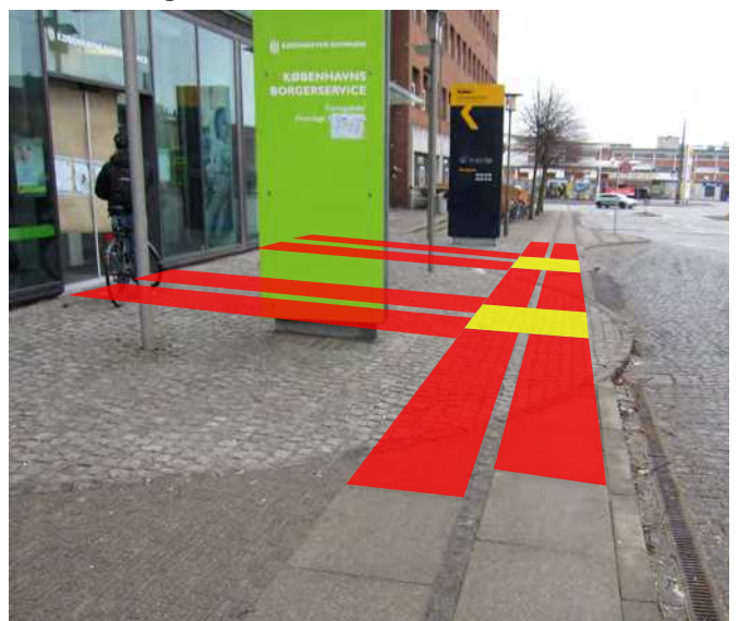
Løsning 15_2: Indgange til bygning forsynes med ledelinie og opmærksomhedsfelt
