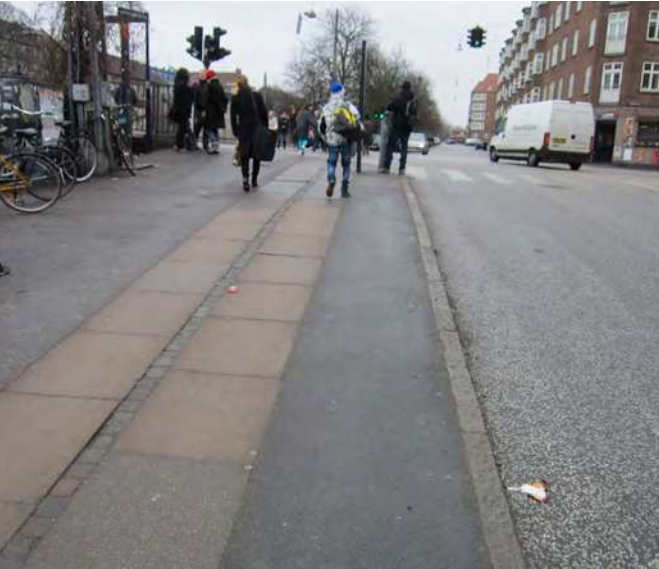
Problem 10_1: stigende terræn på Lyshøjgårdsvej. Stigning 96‰.
