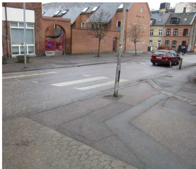
Problem 08_5: Der mangler kobling til opmærksomhedsfelt og ledelinie i fortov.
