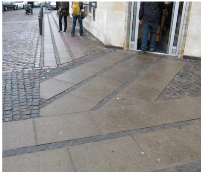
Foto der viser problem 13_2: Forbindelse
