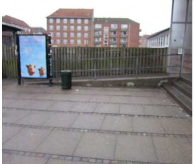
Foto der viser problem 12_2: Rampe
