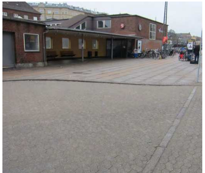
Problem 16_2: Forplads ved hovedbygning
