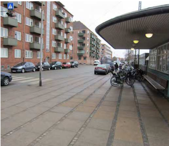
Problem 16_2: Forplads foran Indgang mod tunnel
