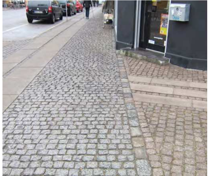
Foto der viser problem 13_1: Tilkobling
