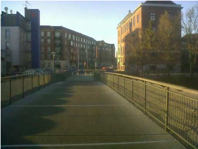
Hønsbroen er ikke delt op i arealer for gående og cyklende, hvilket er utrygt for de svageste fodgængere.
