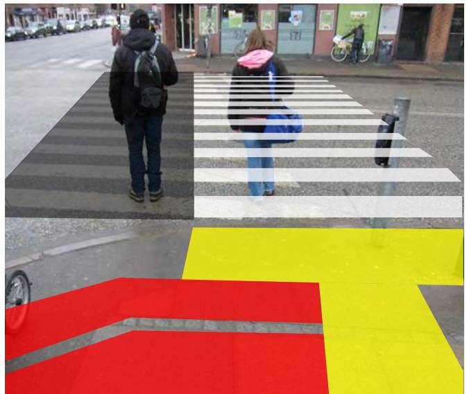
Løsning 17_5: Fodgængerfelter ved hjørner rykkes længere væk fra krydset.
