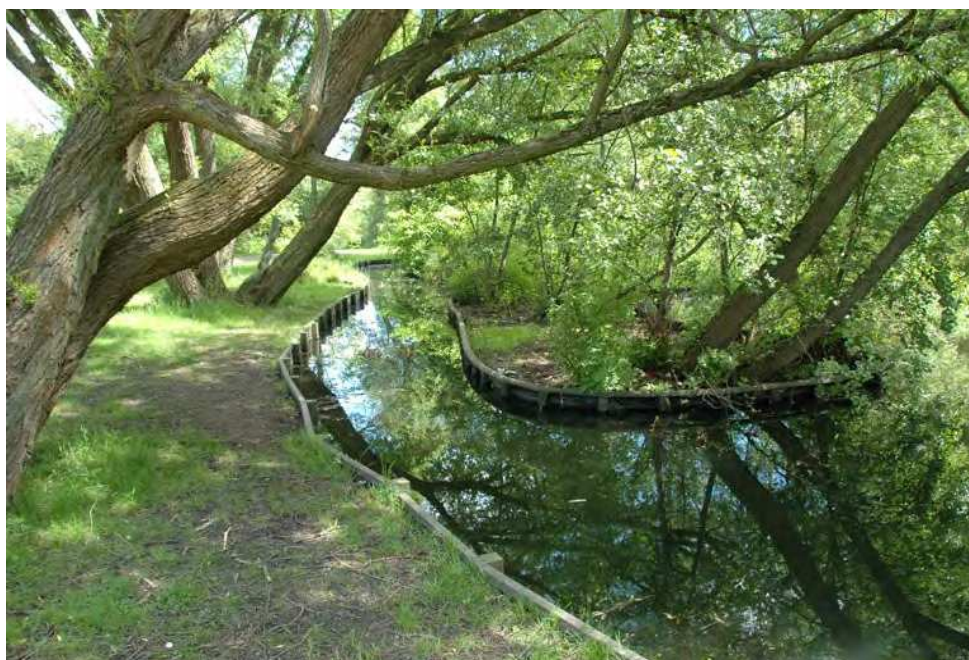
Figur 6-64 Erosionssikring langs kanalerne i Degnemosen begrænser den naturlige overgang mellem land og vand.
