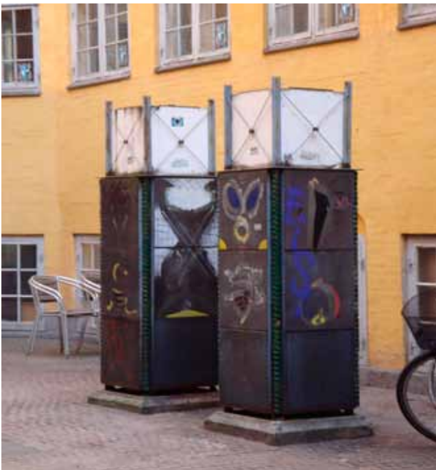
Affaldshåndtering. Eksempel på centralsug for affald i lokalplanområdet.
