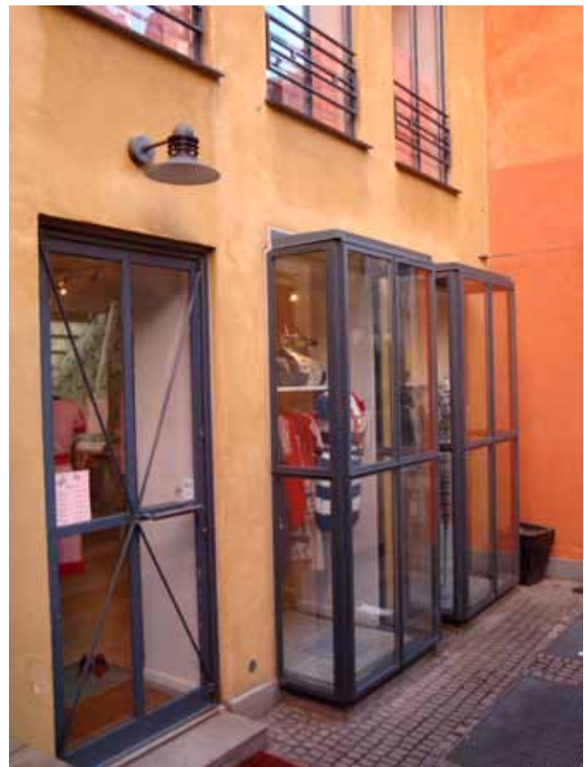
Eksisterende lyskasser kan erstattes med glaskarnapper på butiksfacaden.
