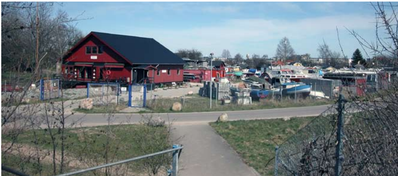
I den sydlige del af lokalplanområdet ligger Bådeforeningen Trekanten. Vejen der løber forbi er forlængelsen af Thomas Koppels Allé, der fører til Mozart.
