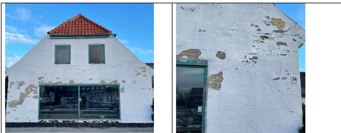
Billede 3 – Bygning 1 Sydlig gavl
