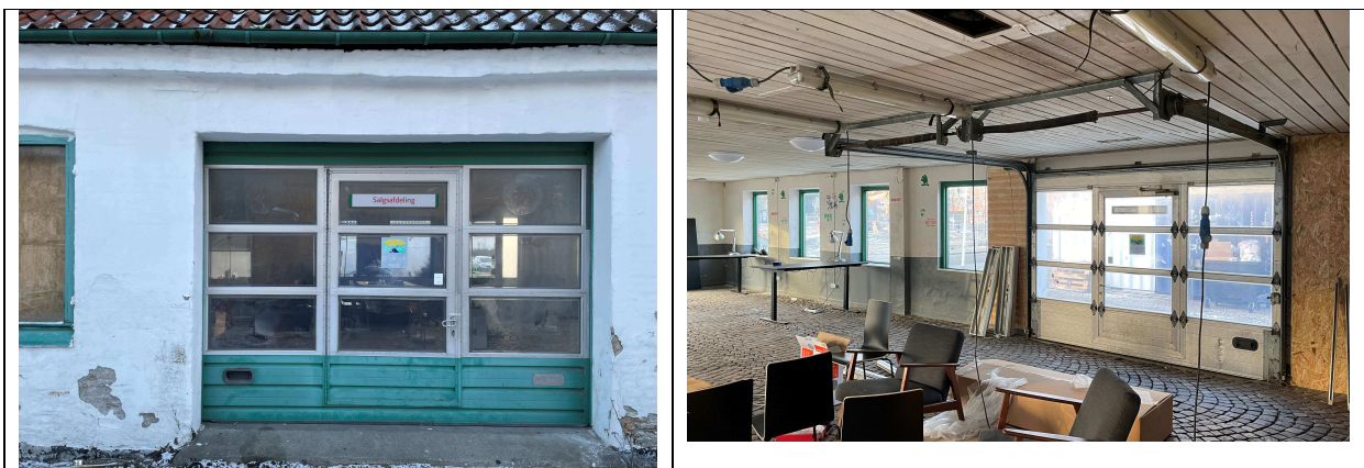
Billede 5 – Bygning 1- Portåbning i vestlig facade udefra samt indefra
