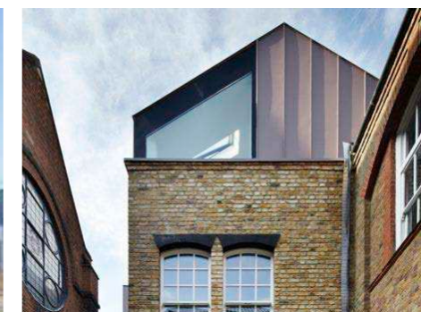
Transformation af omklædningsbygningen
