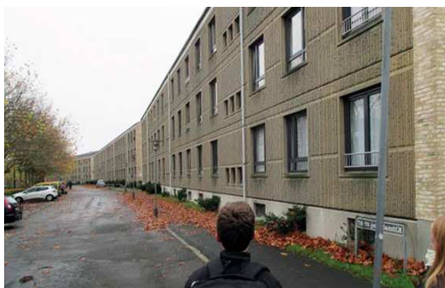
Eksisterende forhold med skalmurede gavle og de oprindelige betonelementer på langsiden
