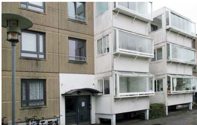
Eksisterende forhold med de karakteristiske altaner
