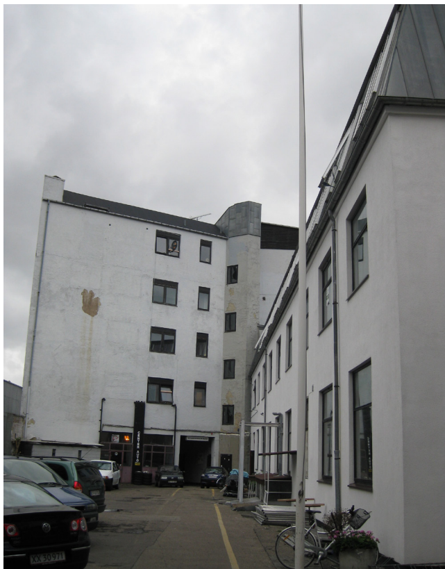
Heimdalsgade 35-37, set fra gårdsiden
