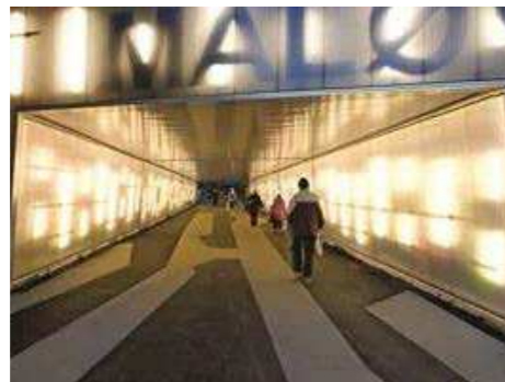
Tunnel med effektbelysning
