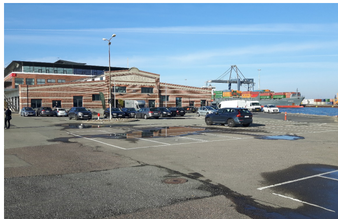
Den nuværende parkeringsplads hvor byggeriet opføres. Det eksisterende pakhus ligger udenfor tillæggets område og forudsættes bevaret, i den eksisterende lokalplan for Sundmolen.
