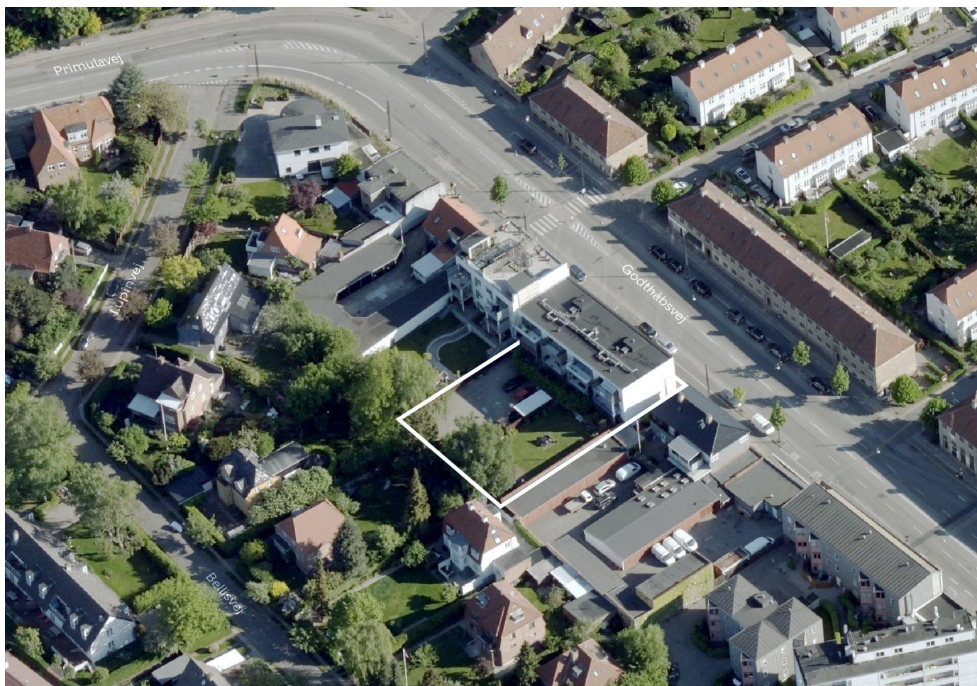
Området set mod nord. Lokalplanområdet er indtegnet med hvid linje og de vigtigste gader er navngivet. Luftfoto: Kortforsyningen, 2017.
