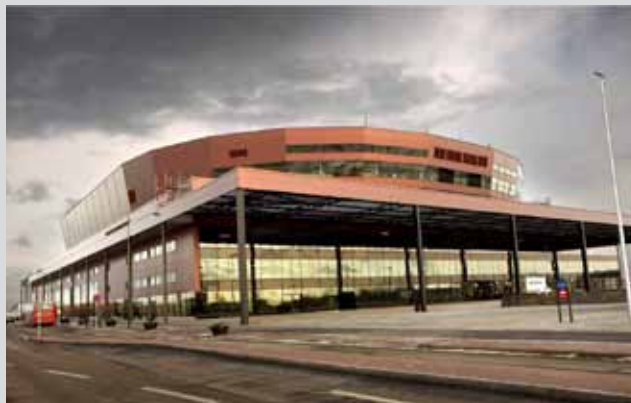
Hyllie Arena i Malmö-forstaden Hyllievång med 15.500 tilskuerpladser er centralt placeret i et nyt byudviklingsområde og kan i størrelse og anvendelse sammenlignes med den i Ørestad planlagte multiarena.
