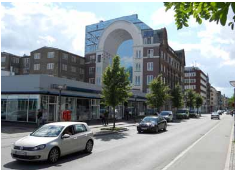
I forgrunden Den Hvide Kødbys randbebyggelse mod Halmtorvet. Bagved ses Halmtorvet 29 (med gavlmaleri af Peter Abelin), der er ombygget til ejeboliger.
