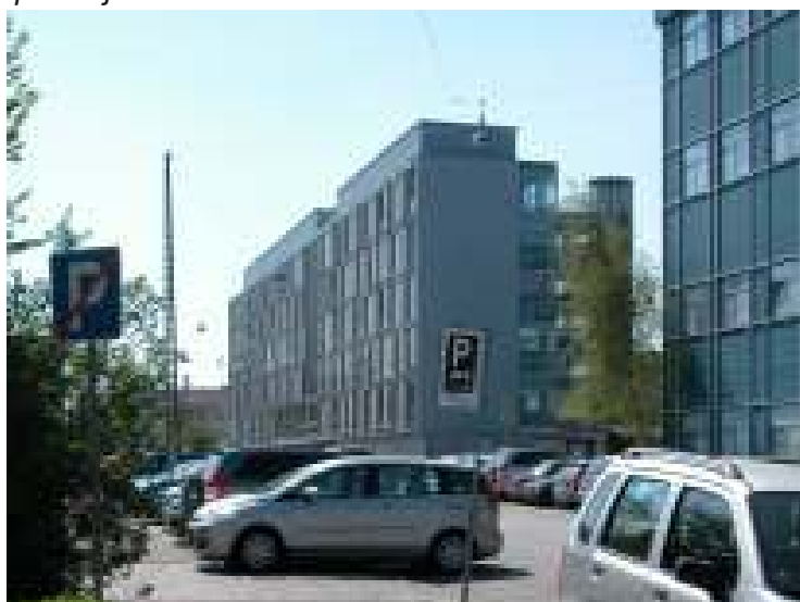
Industrikollegiet i Rådmandsgade.
