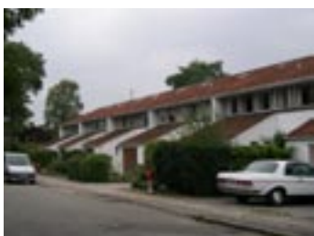
Rækkehusene ved Kildevænget.
