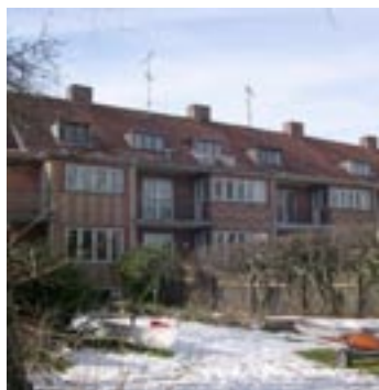
Østfacade på rækkehus ved Soldalen med kvist, karnap og overdækket altan.
