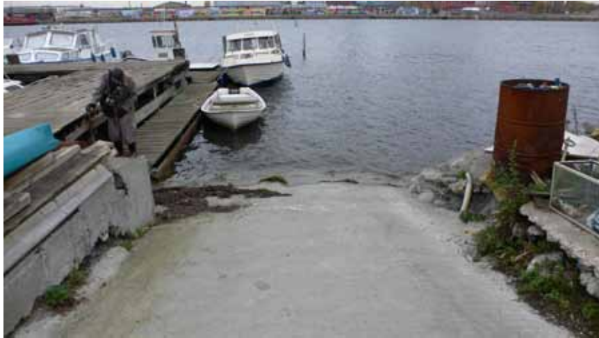
Eksisterende sliske i betonkanten
