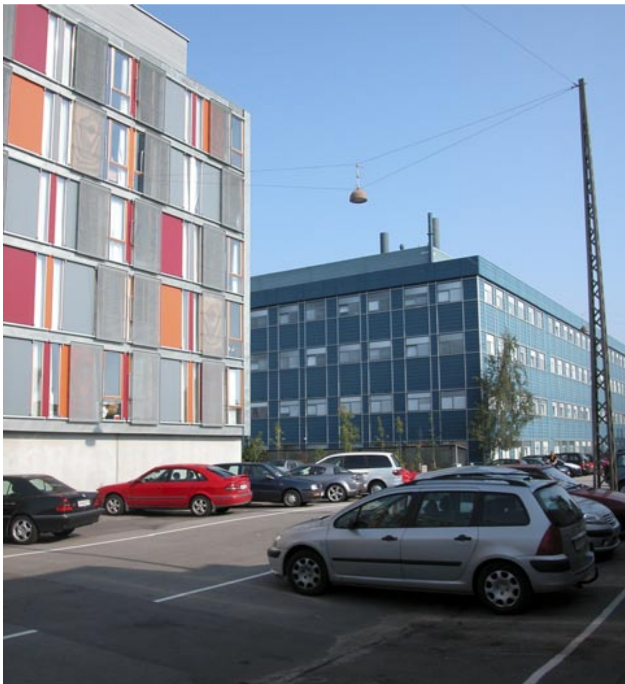
Industrikollegiet og Laborantskolen set fra Rådmandsgade. Laborantskolen vil indgå i det samlede kompleks.
