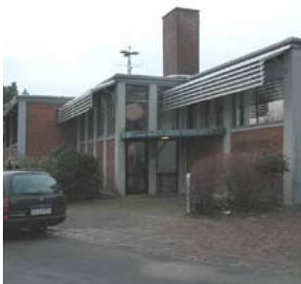
Amager Strandvej 124 var i helhedsplanen tænkt nedrevet og erstattet af nybyggeri. Lokalplanen fastlægger bygningen som bevaringsværdig, med mulighed for tilbygning.
