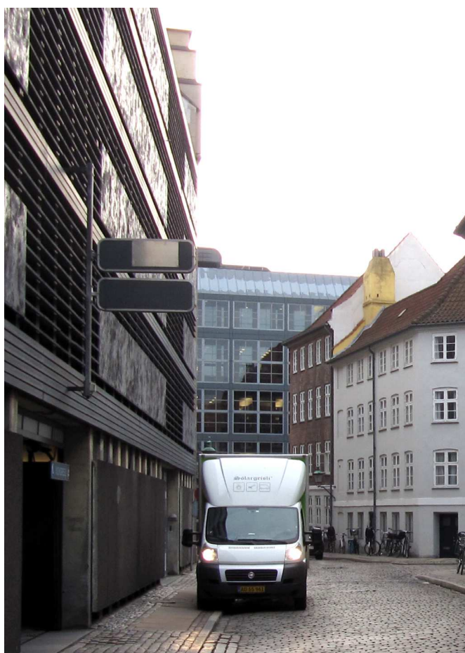
Til venstre p-huset i Asylgade, som erstattes af et nyt byggeri. For enden ses glasbygningen på Bremerholm, som må ombygges.
