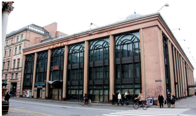
I 1988-1989 blev Scala, tegnet af arkitekten Mogens Breyer, opført med butikker, restauranter, fitnesscenter, biograf samt et diskotek i hælderens.
