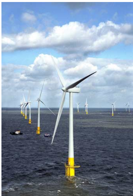
Figur 5.9 Vindmøller på monopæle.
