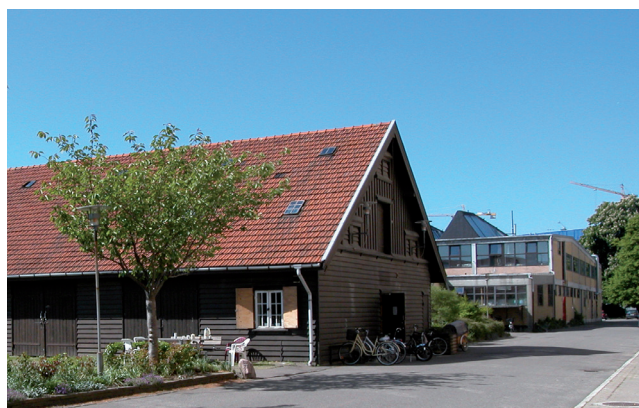
Bevaringsværdig bygning med opbevaring af materiel
